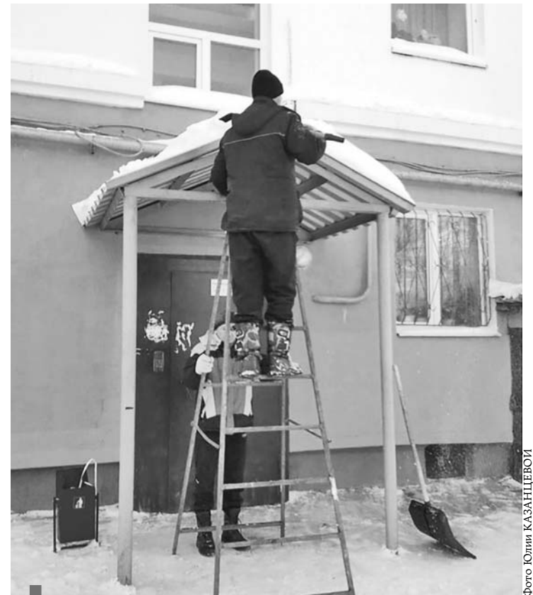
Сброс снега с козырьков подъездов
