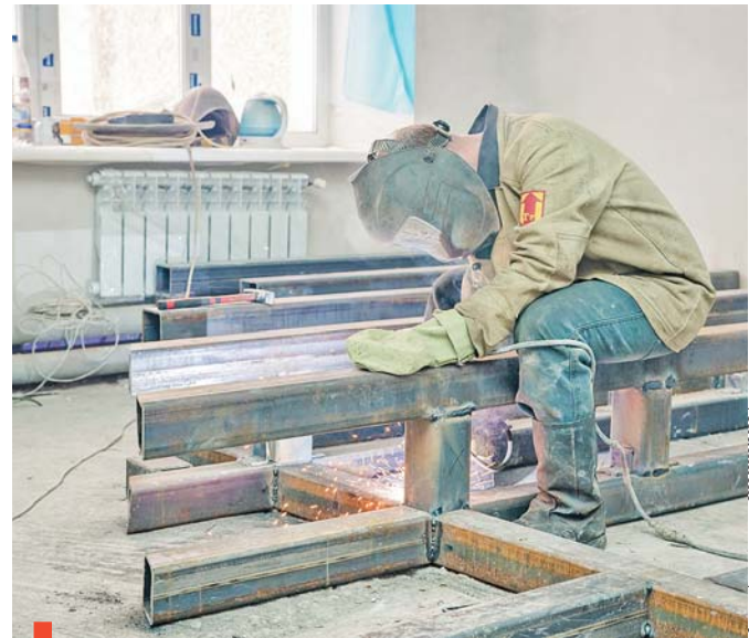
Идет сборка металлоконструкций
