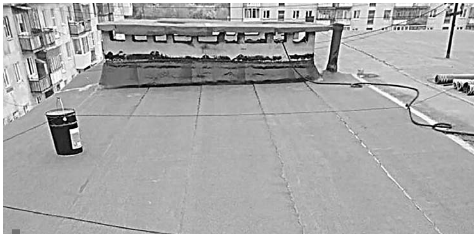
Ремонт кровли дома №1 по переулку Буденного
