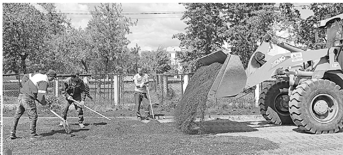
Обустройство спортивной площадки
