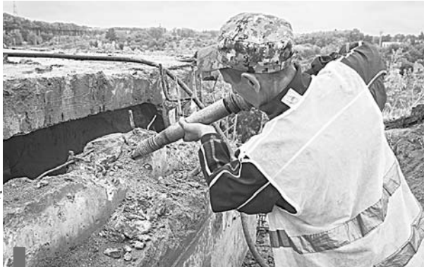
Демонтаж переходных плит
