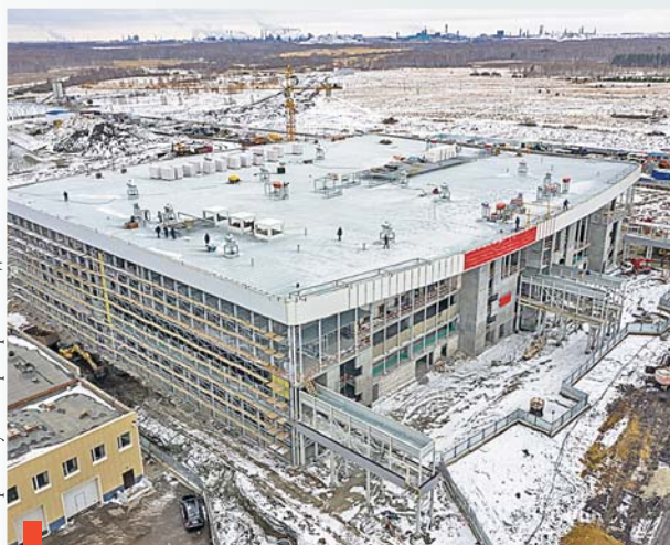
Строительство аэропорта в Челябинске
