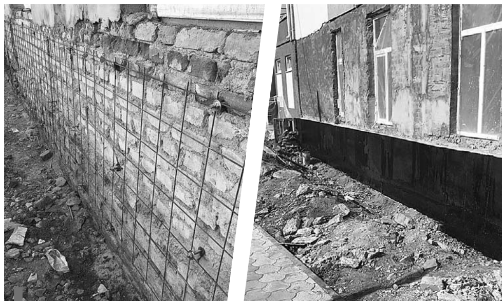
Укрепление кладки анкерами и покрытие гидроизоляцией
