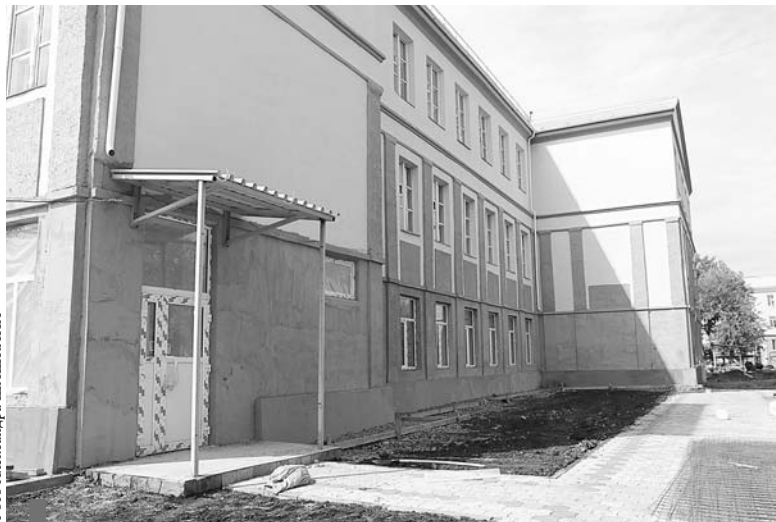
Фасад здания школы №7 почти готов
