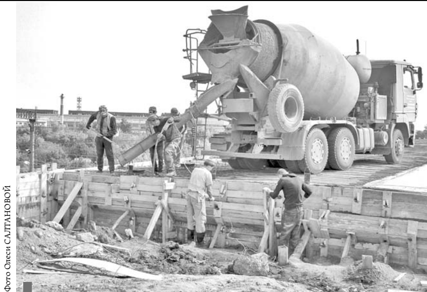
Бетонирование второй шкафной стенки
