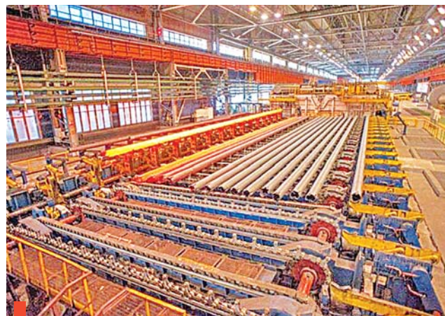
Современный трубопрокатный цех Северского трубного завода
