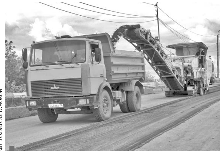
Срезка старого покрытия
