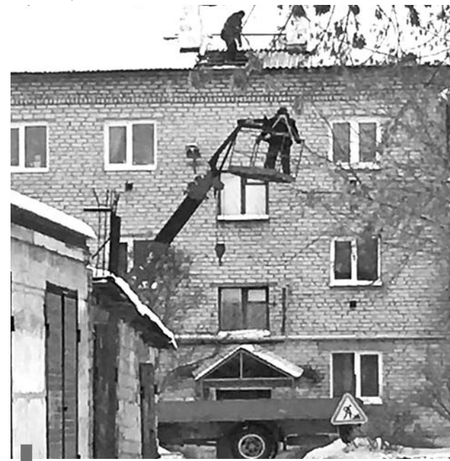
Текущий ремонт кровли дома №9А по пер. Буденного
