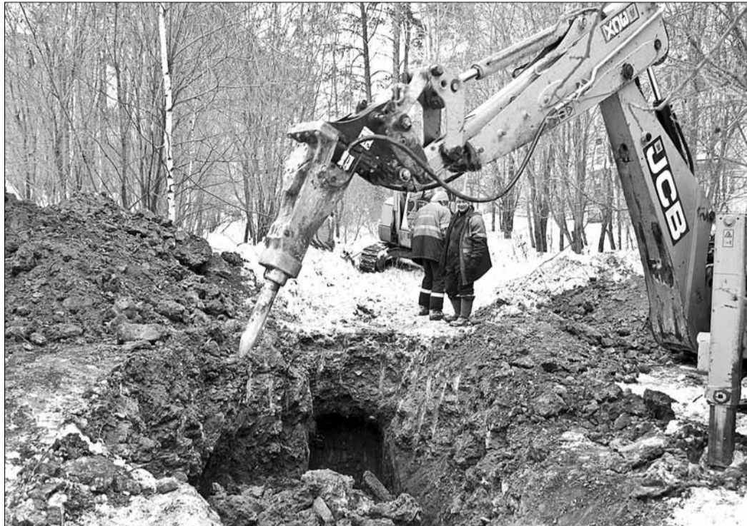
Рабочие компании «Газтепломонтаж» копают замерзший грунт в районе подключения новой магистрали к действующей газовой трассе — у дома № 4 по ул. Спортивной. Фото Олега Манварова
