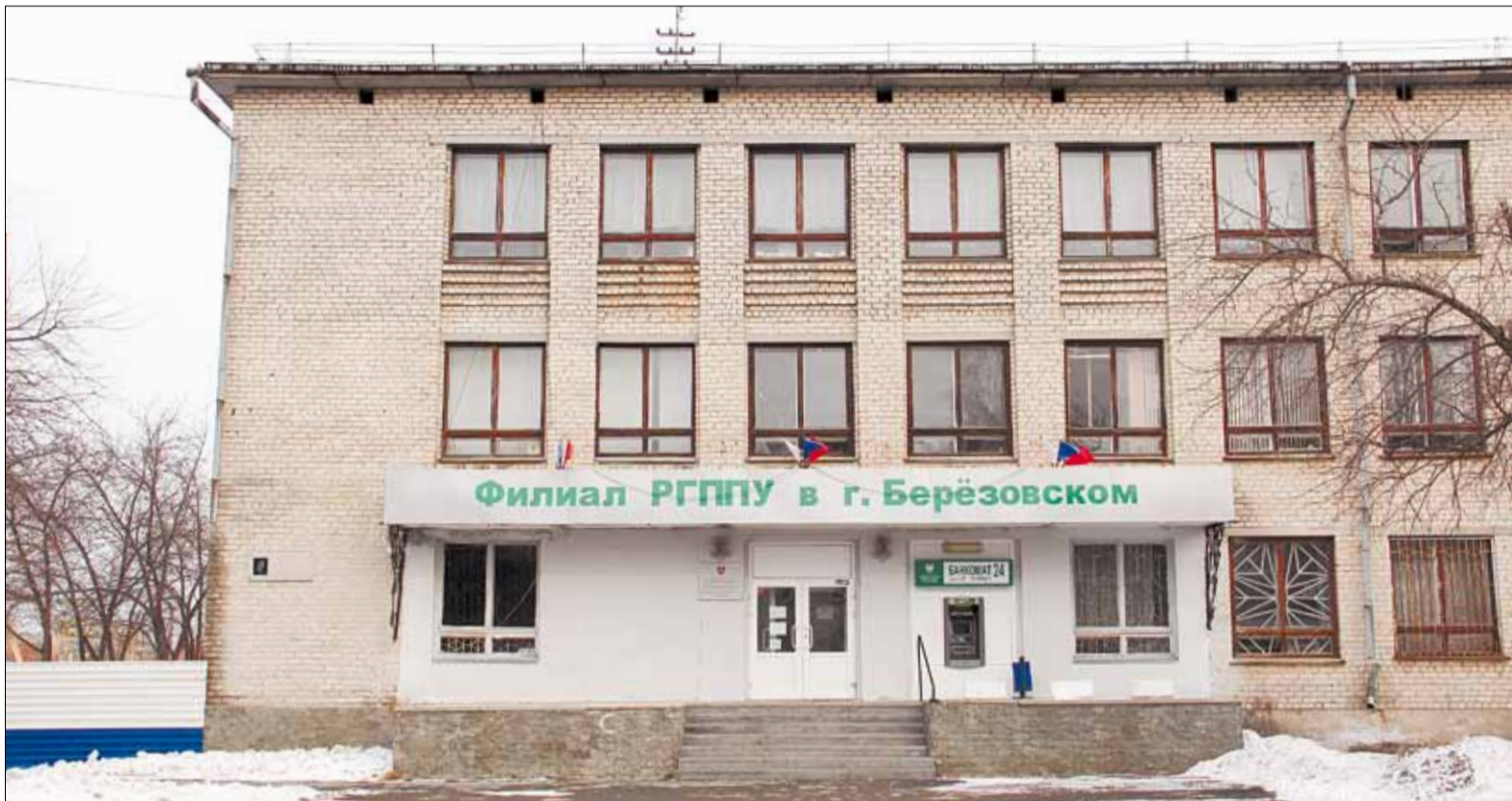
В ближайшем будущем здания филиала РГППУ в городе Берёзовском попадут в руки нового хозяина
