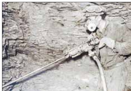
Забуривание шпура, разведочная шахта № 56
