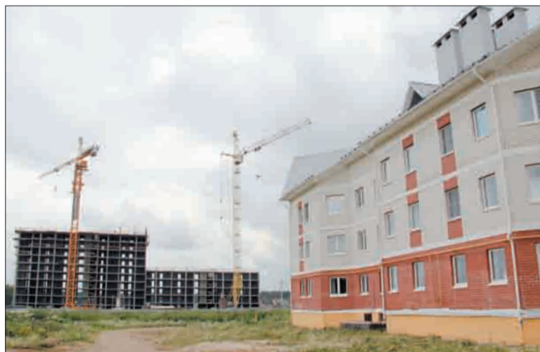
Рядом с домами на ул. Виктора Чечвия и Николая Жолобова началось строительство многоэтажного жилого комплекса «РябинаПарк». Жители надеются, что с его сдачей в эксплуатацию в Шилловском микрорайоне появятся магазины и аптека, которых сейчас очень не хватает
