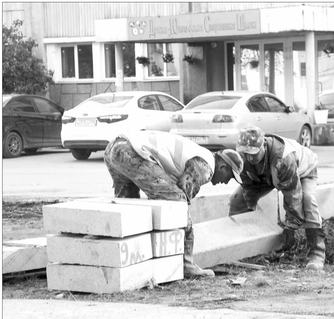
Рабочие устанавливают новые бордюрные камни из гранита на ул. Брусницына. Фото Павла Шабельникова
