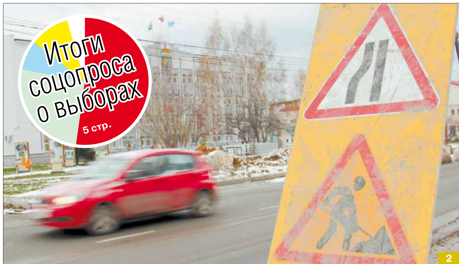
Коммунальщики вплотную «подобрались» к зданию администрации города Берёзовского. Под окнами мэра перекопан тротуар и часть дороги. Фото Павла Шабельникова
