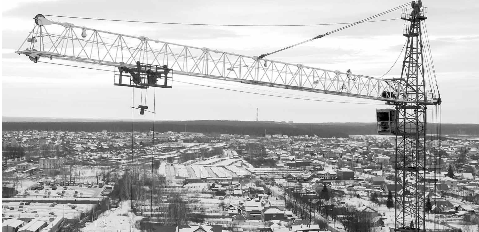
Башенный кран возводит многоэтажный дом на ул. Восточной в центре Берёзовского. Фото Павла Шабельникова
