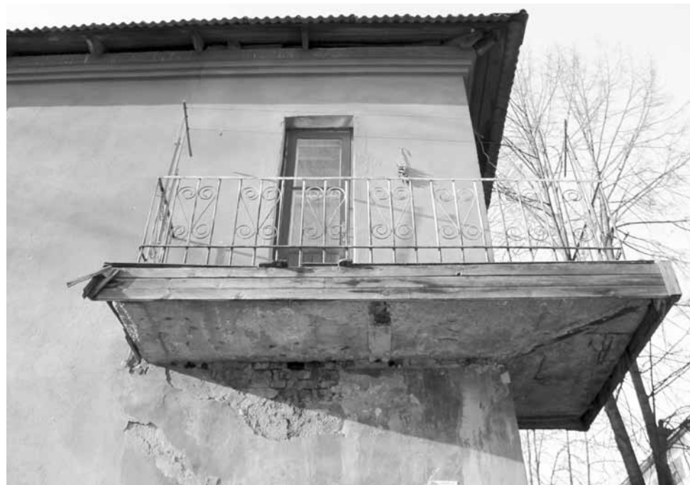
Дом № 7 по ул. Циолковского – кирпичный с деревянными перекрытиями. Подлежит расселению до 2017 года. Фото Павла Шабельникова
