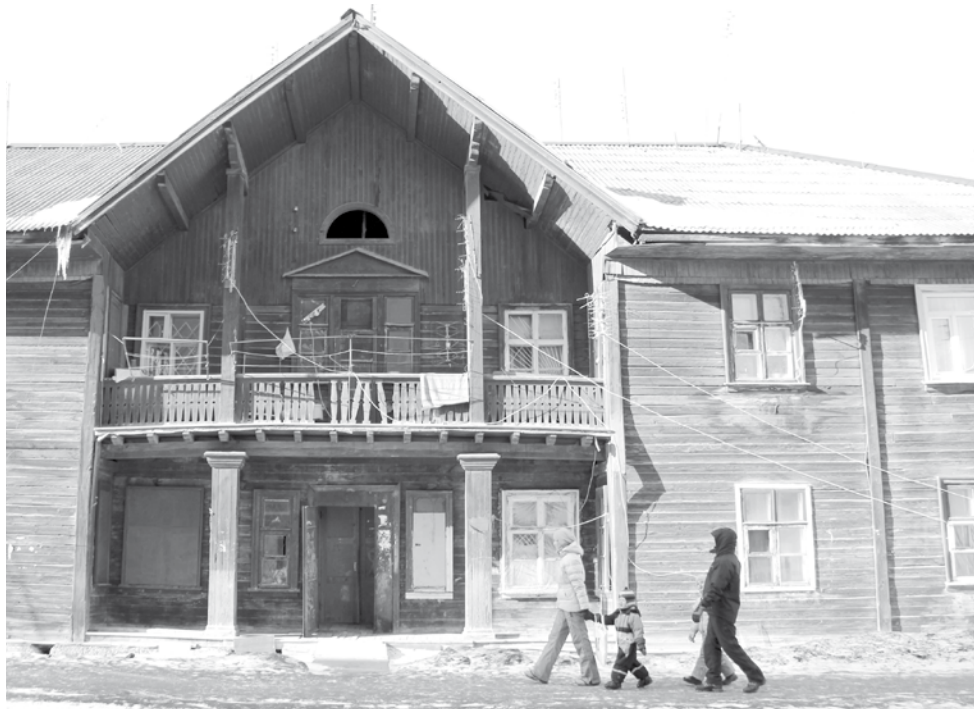
Дом № 19 по ул. Энергостроителей, один из самых «знаменитых» своими проблемами берёзовских барачков. Подлежит расселению до 2017 года
