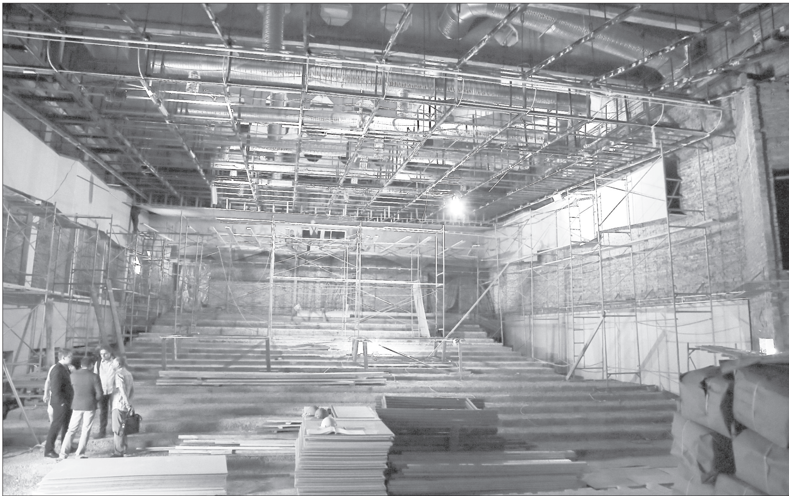
В зрительном зале «Современника», вместимость которого предполагается в 396 мест, стоят леса для монтажа потолка из гипсовых панелей. Фото Павла Шабельникова
