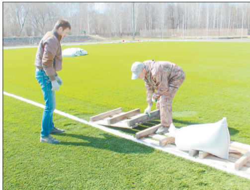
С помощью поддона и тяжелого мешка выравнивается склейка уложенной ленты разметки с газоном поля. Фото Николая Королева
