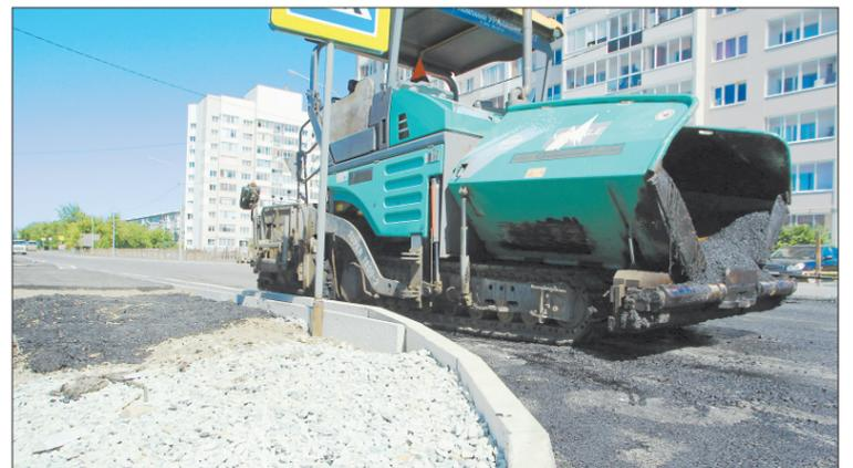
**6** Следующая точка на карте – улица Красных героев. Здесь проезжая часть почти готова, остались доделки: установка тротуарных ограждений, устройство газонов, разметка переходов. Автомобили по ней уже ездят.
