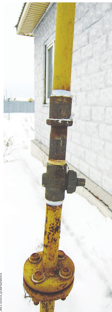
Через эту трубу здание наконец подключили к благам цивилизации.
