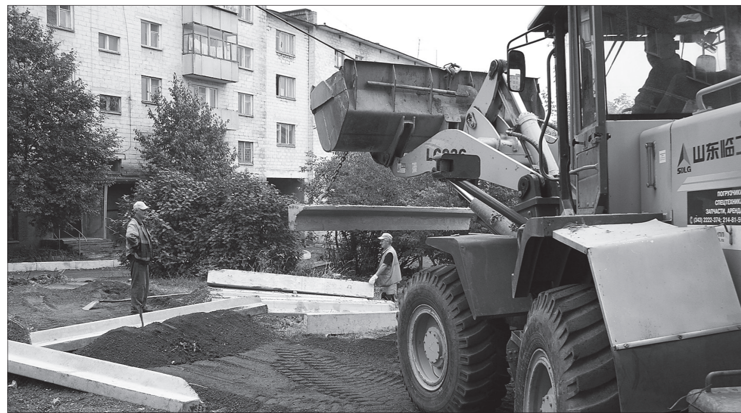
* Идет реконструкция двора.
