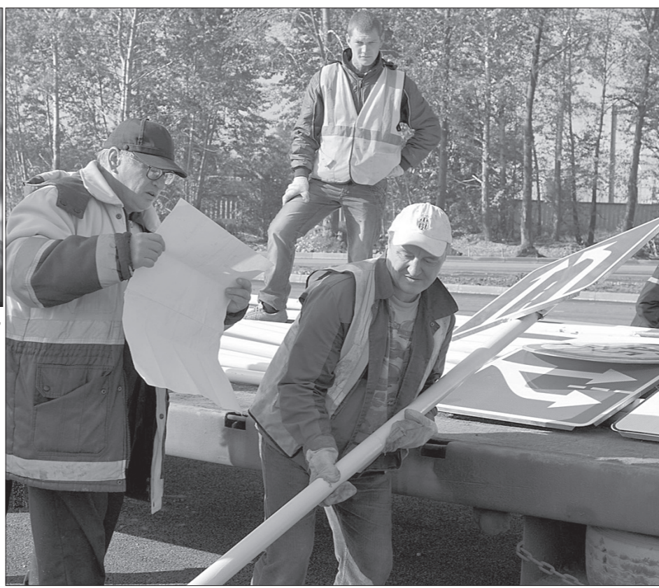
Евгений Гусельников руководит монтажом дорожных знаков.
