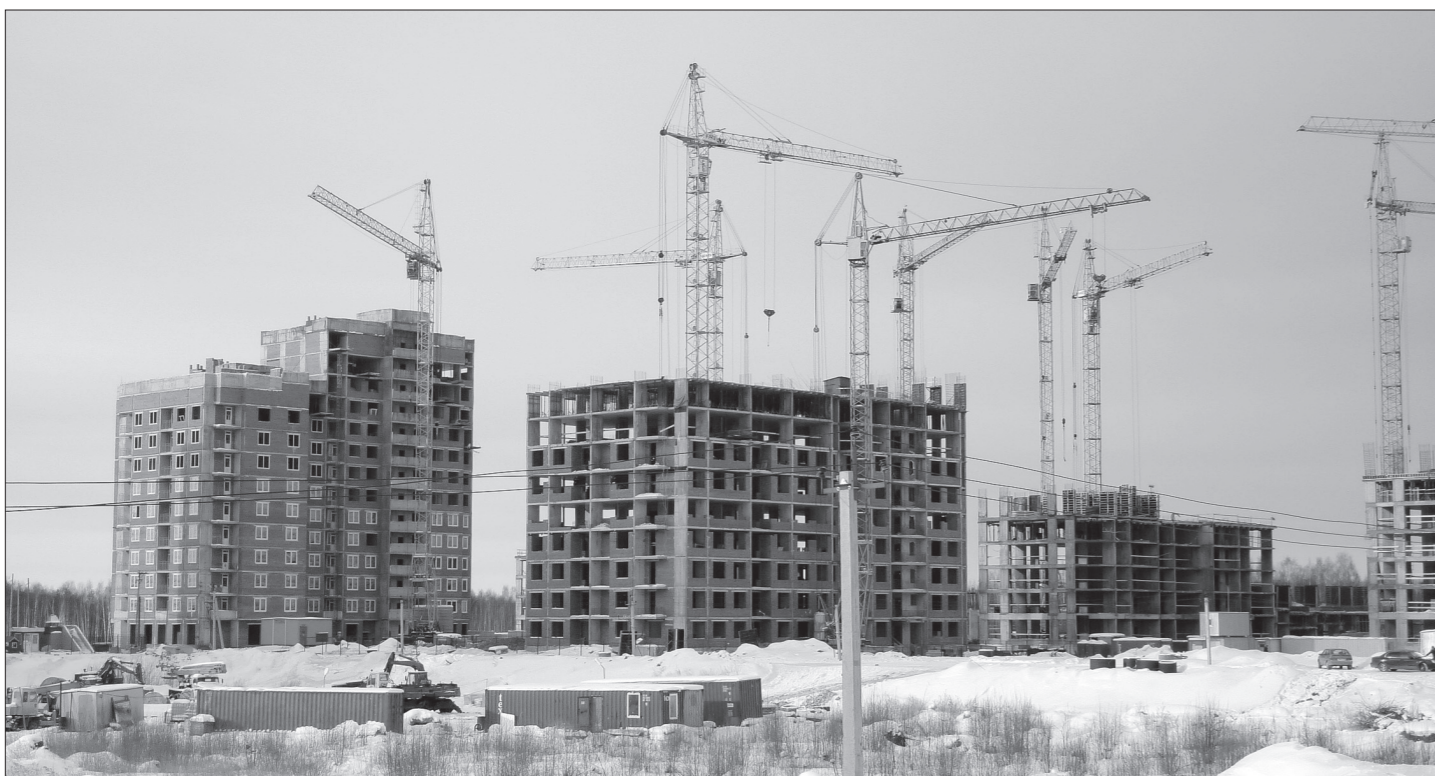
Строительство Академического идет активными темпами. ФОТО АВТОРА.
